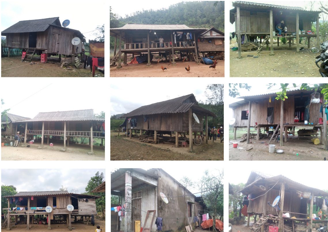
Hình 5: Hiện trạng nhà ở tại xã Mò Ó
