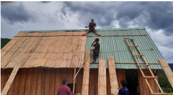
Hình 7: Mái nhà lợp tôn và phủ thêm một lớp gỗ ô dệp phía trên
